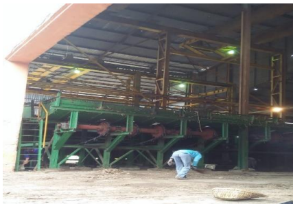
GAMBAR 1. Salah satu pekerja tidak menggunakan APD
