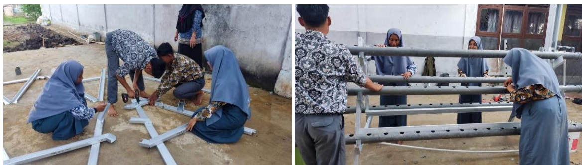
Gambar 1. Proses perakitan instalasi hidroponik
